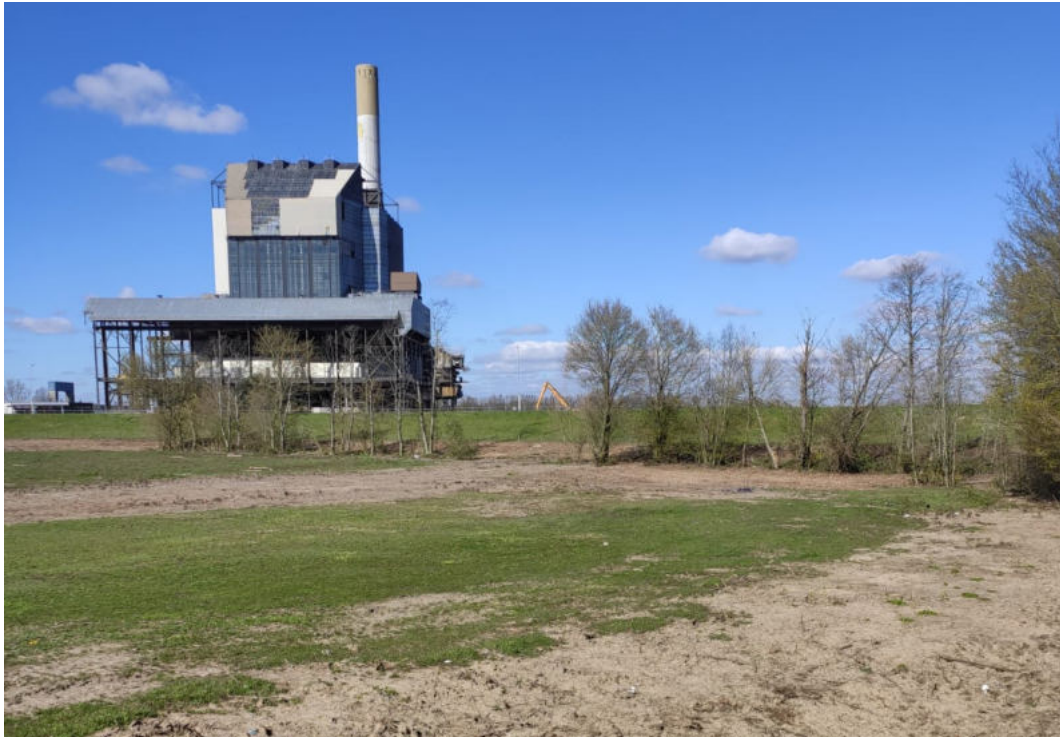
Foto 1 Overzicht van plangebied vanaf de oostelijke hoek.
