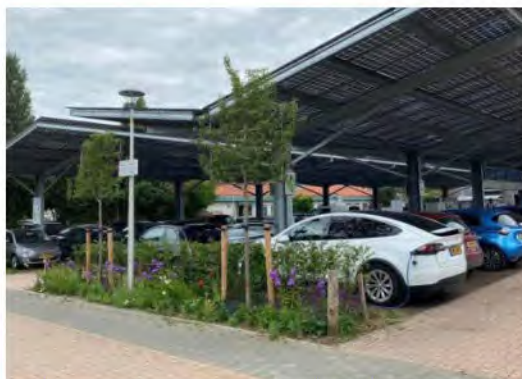
parkeren onder een zonnepanelendek i.c.m. groen en halfverhard parkeren
