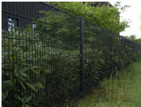
hekwerk tegen de groenbuffer
