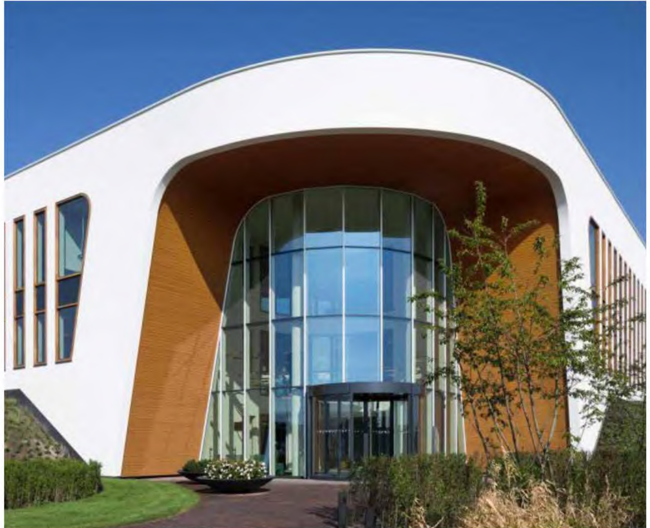
voorgevel waarbij bovenstaande uitgangspunten zichtbaar zijn
