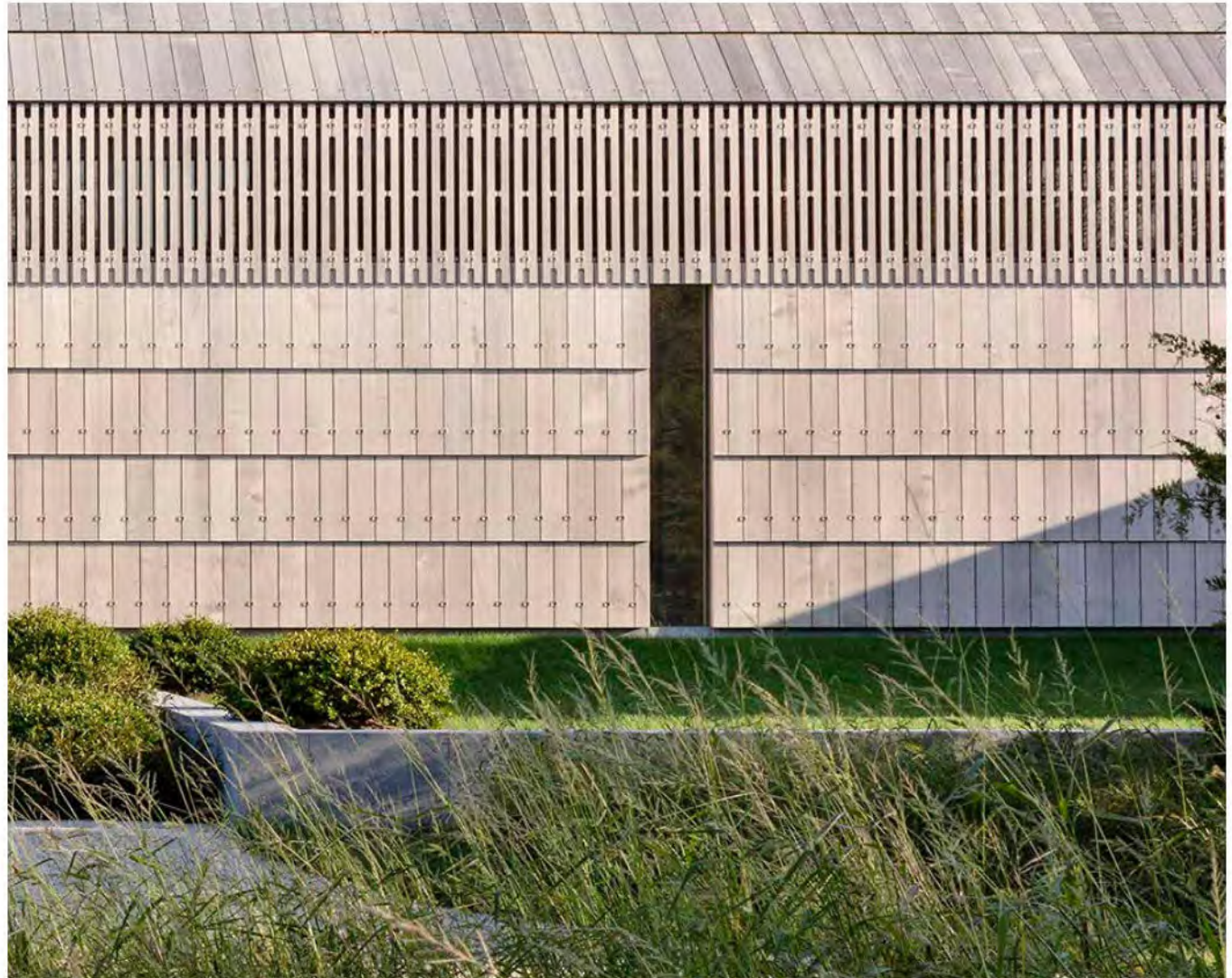
achtergevel waarbij één materiaal in elementen is aangebracht
