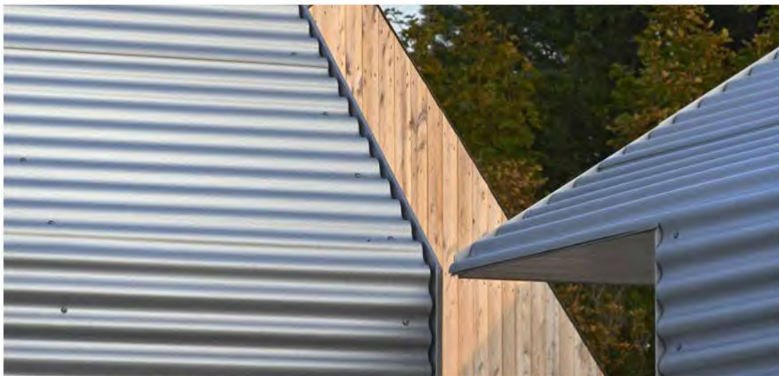
golfplaatgevel versterkt zichtgevels
