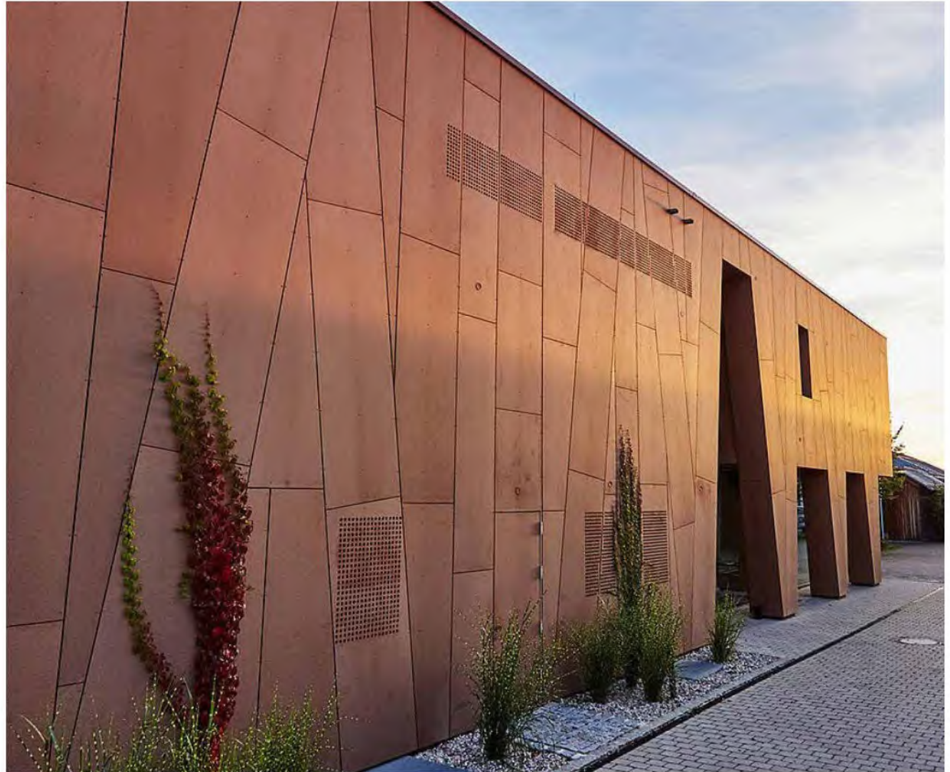
voorgevel waarbij bovenstaande uitgangspunten zichtbaar zijn
