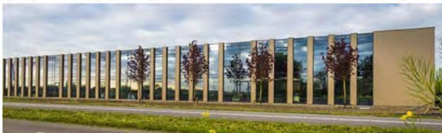
speling van open en gesloten in de gevel
