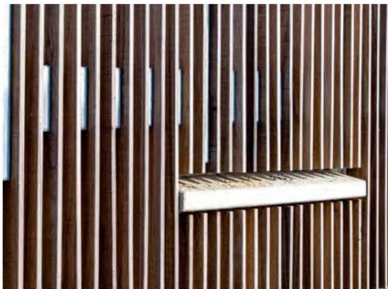
vleermuizenverblijf in constructie verwerkt
