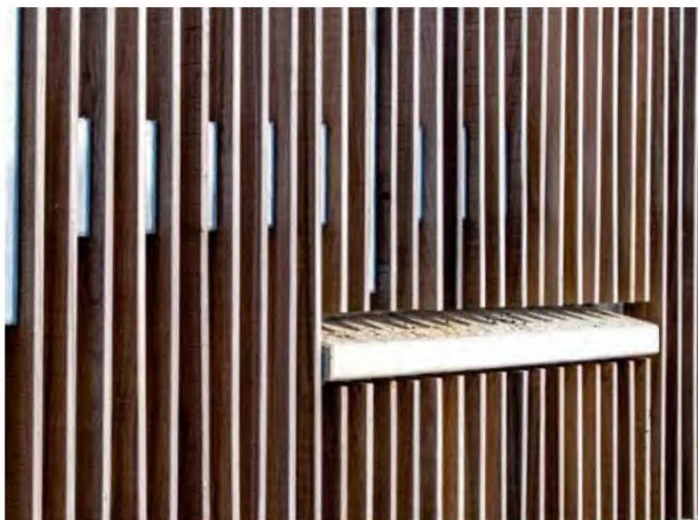
vleermuizenverblijf in constructie verwerkt
