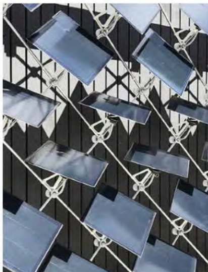
zonnepanelen op de gevel
