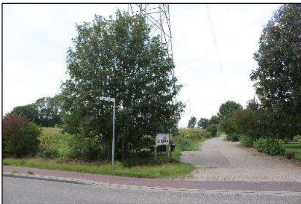
Foto 5: Einde eerste HDD boring.
