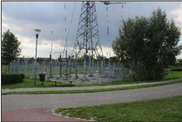
Foto 1: Start tracé bij hoogspanningsmast.
