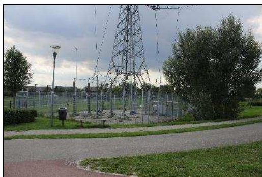
Figuur 4.2. Intredepunt nabij mast 12.
