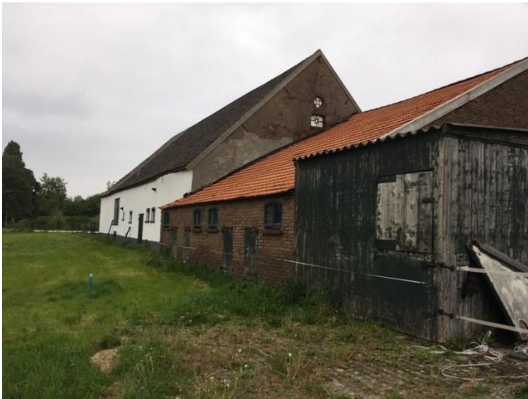
• Afbeelding 9; Zijaanzicht van de te slopen gebouwen
