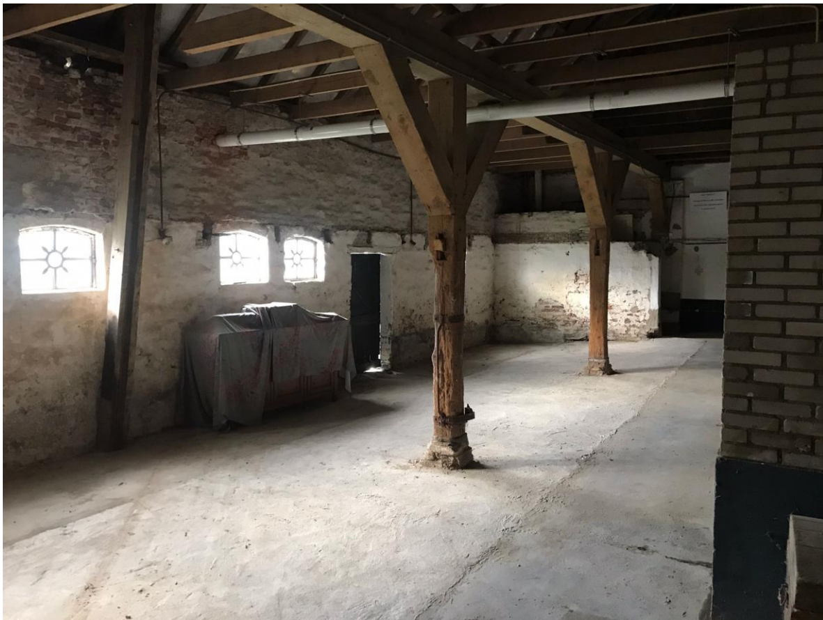
• Afbeelding 12; Binnenzijde stal met steense muren
