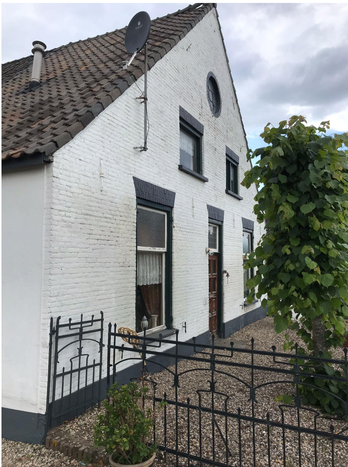
• Afbeelding 7; Aanzicht/ voorgevel van de te slopen gebouw foto's 2022
