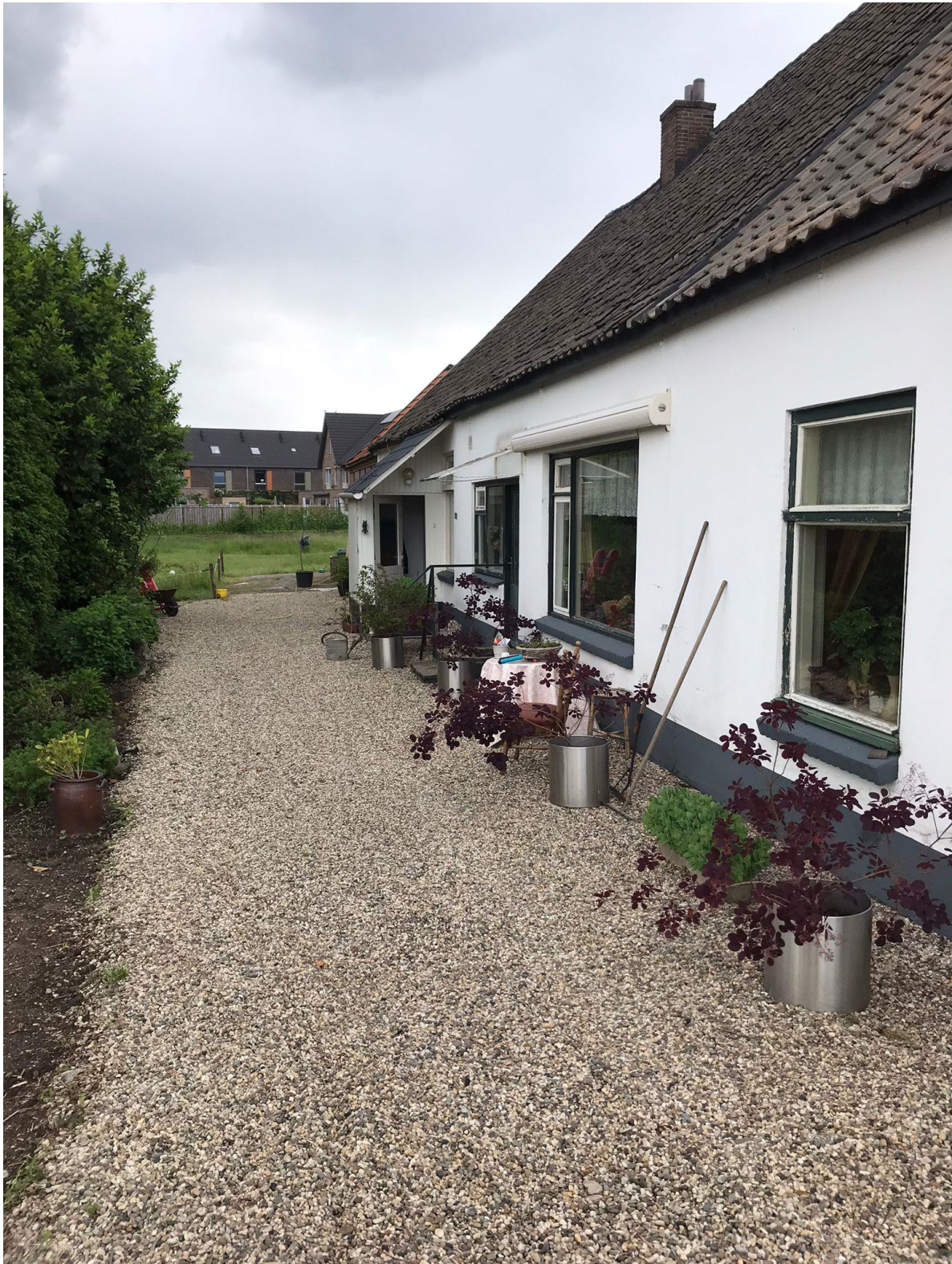
• Afbeelding 8; Zijaanzicht van de te slopen gebouwen
