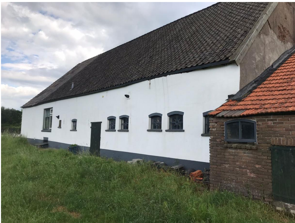
• Afbeelding 10; Zijaanzicht woongedeelte van de te slopen gebouwen
