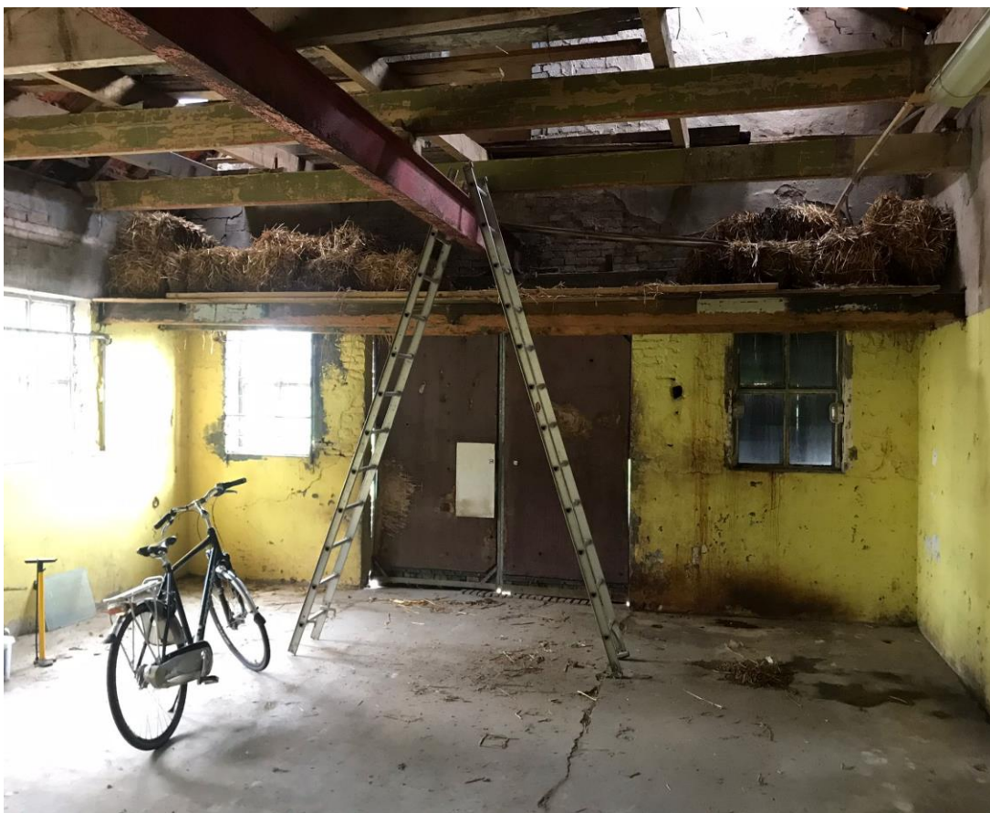
• Afbeelding 11; Binnenzijde te slopen stalgebouw
