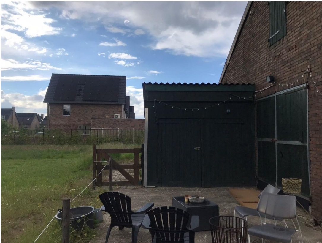
• Afbeelding 11; Achterzijde van de te slopen gebouwen (ingang paardenstal)
