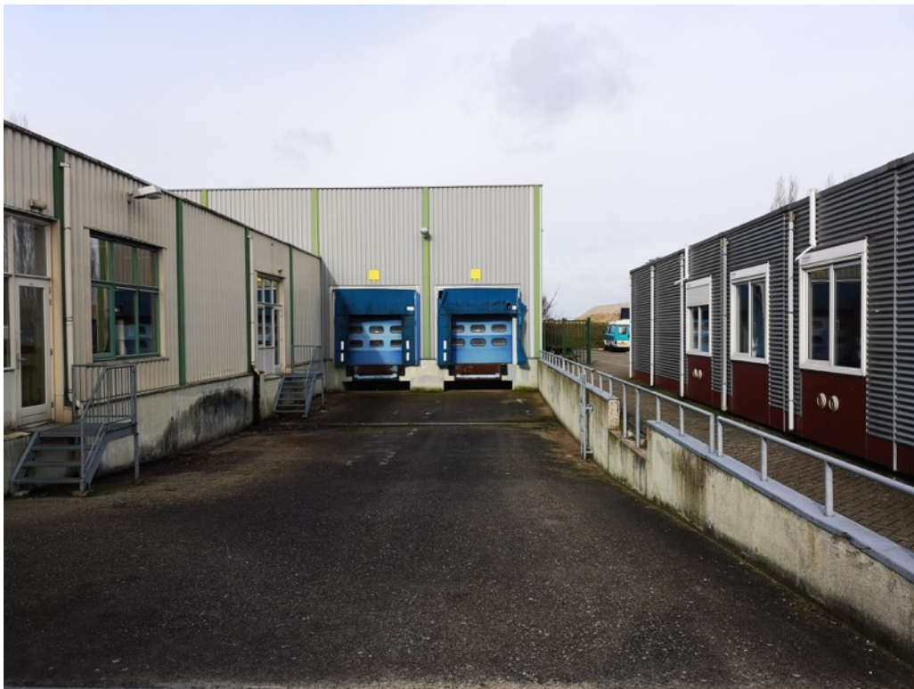
Foto 2 Loods aan achterzijde van de school.
