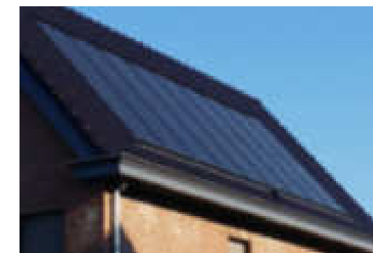
Referentie: zonnepanelen afgestemd op kleur dakbedekking
