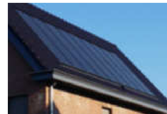
Referentie: zonnepanelen afgestemd op kleur dakbedekking
