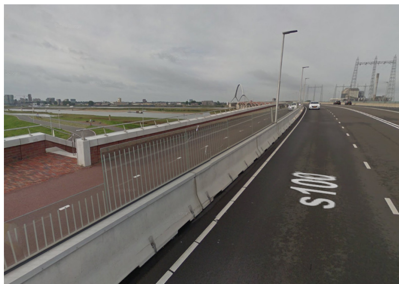
Het bestaande scherm op de Oversteek
