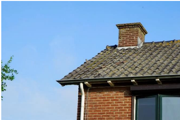
Close-up van het dak met aanwezige huismussen.
