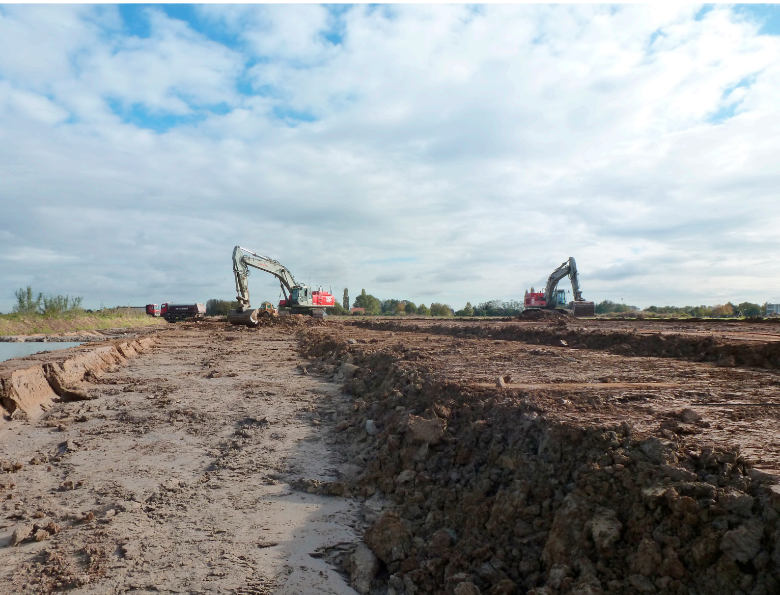
Figuur 2.1. Het gefaseerd afgraven van de klei in segment C.
