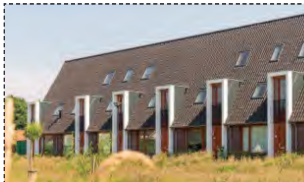
Referentie schuurwoningen (Geerpark, Vlijmen)
