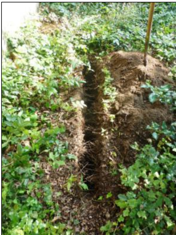
Foto 7: proefsleuf nabij de gevel van het GHC
