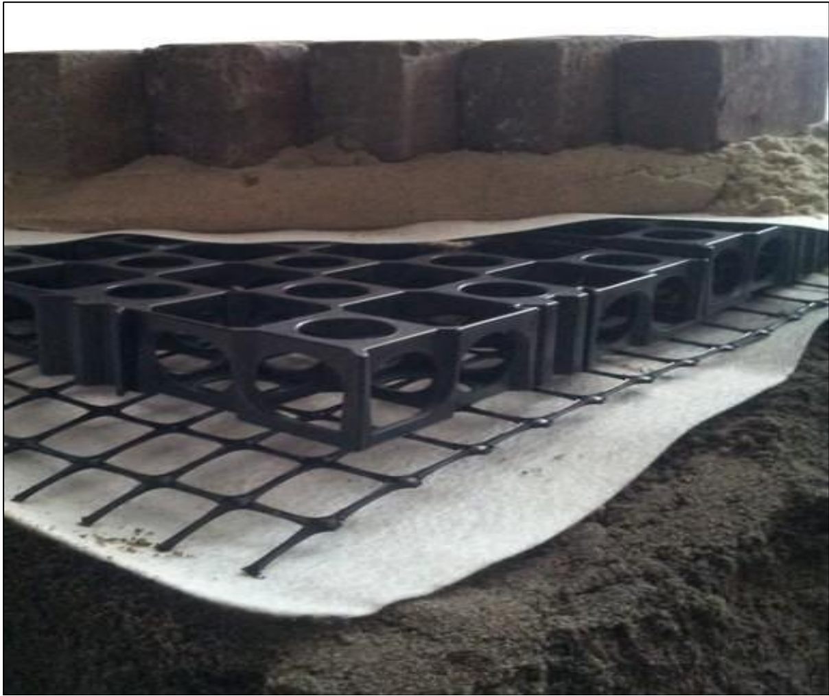
Afbeelding 4: voorbeeld van een sandwichconstructie
