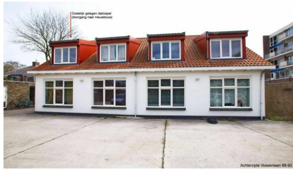
Figuur 4b: Achterzijde Vossenlaan 88-90.
