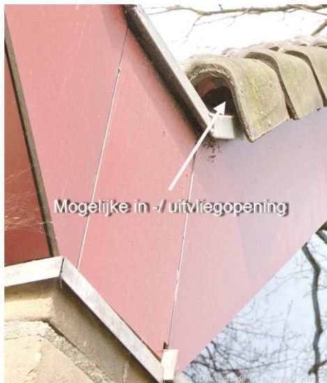
Figuur 5d: Mogelijke in- / uitvliegopening vleermuizen Vossenlaan 76
