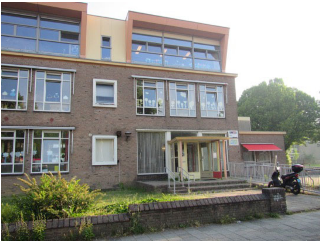
Figuur 3 Hoofdingang aan de zuidzijde van het schoolgebouw.
