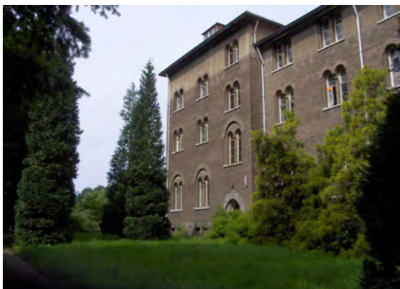
9) Aanleg aan de zuidzijde van het klooster.
