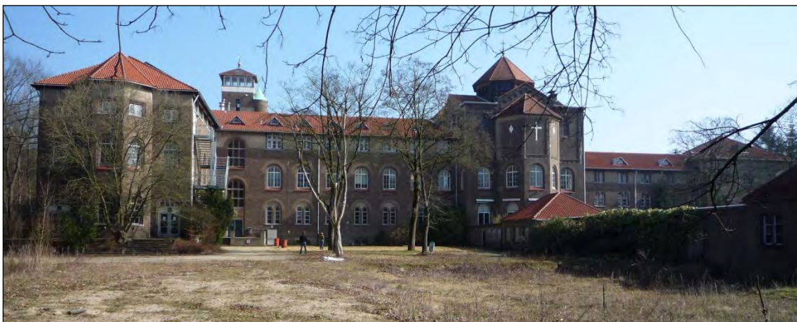
Linksboven: linkerzijde van de voorgevel: kloostergedeelte. Rechtsboven: kerk. Midden: rechterzijde van de voorgevel: juvenaat. Onder: Achtergevel met links het juvenaat en rechts (achter de kassen is de gevel van het kloostergedeelte zichtbaar)
