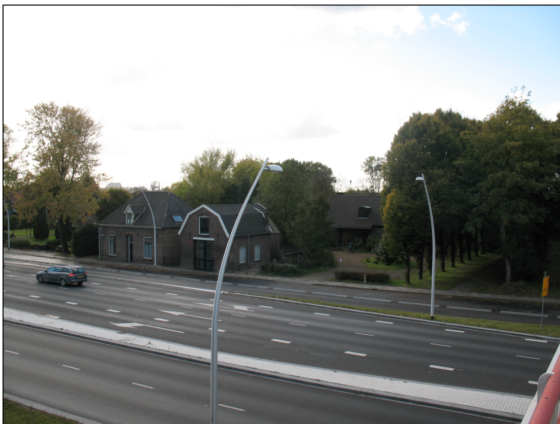
Figuur 3. De te slopen huizen aan de Griftdijk Zuid.
