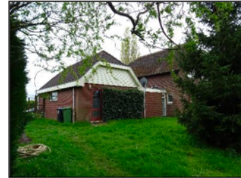
Figuur 5. Uitbouw garage gezien vanuit noordzijde.
