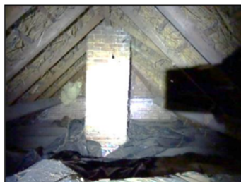
Figuur 9. Zolder van het woonhuis.
