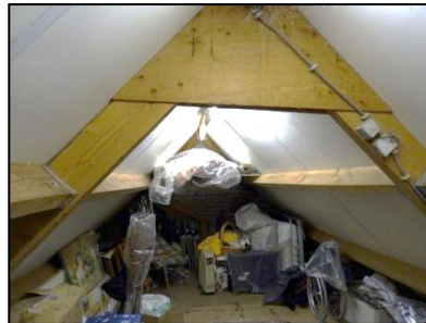
Figuur 10. Zolder van de garage.
