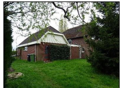
Figuur 5. Uitbouw garage gezien vanuit noordzijde.
