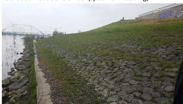
Foto 4 Foto van de kade en de aanwezige begroeiing
