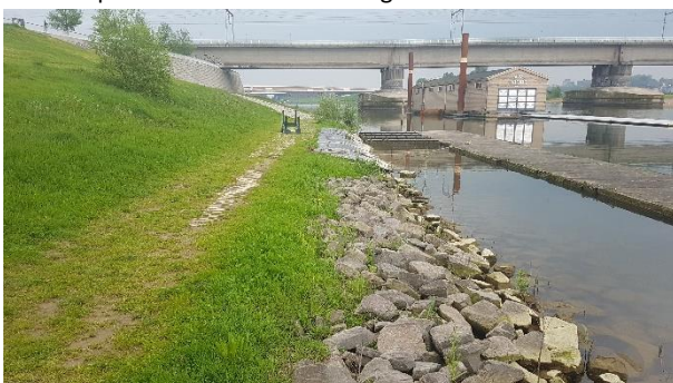
Foto 5 Foto van de huidige steiger en de roeiloods
