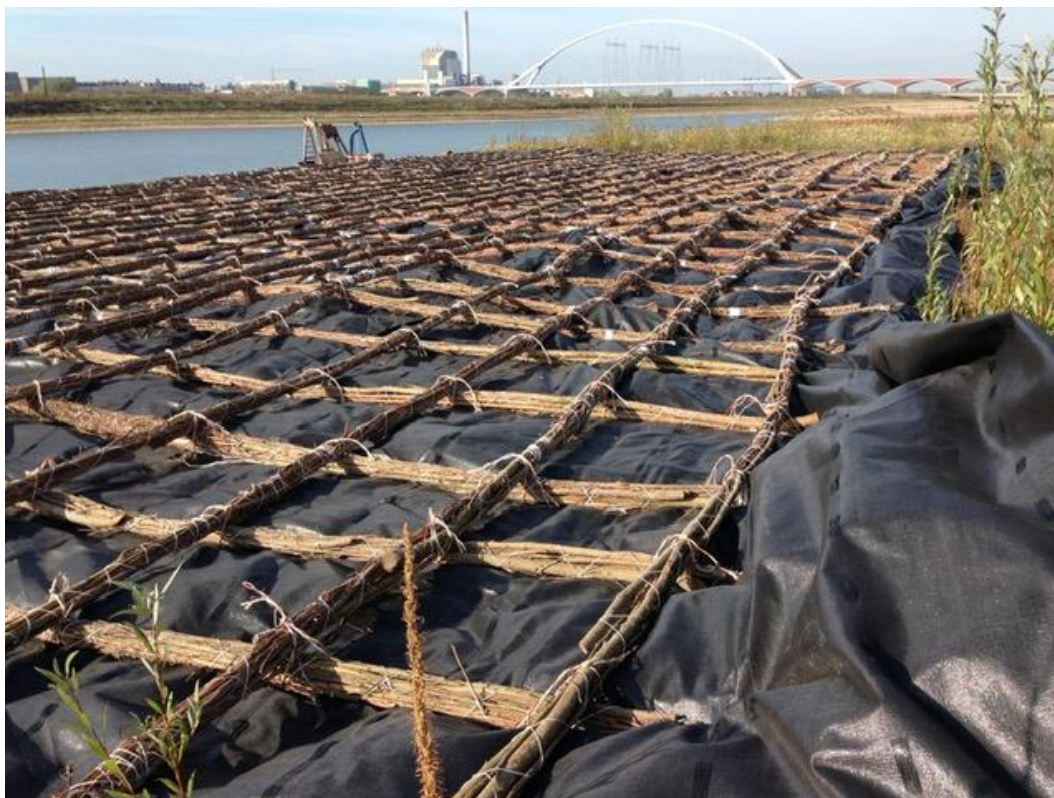
Figuur 3. Het doek dat op de bodem is geplaatst vanaf de paaltjes in figuur 2 de nevengeul in.
