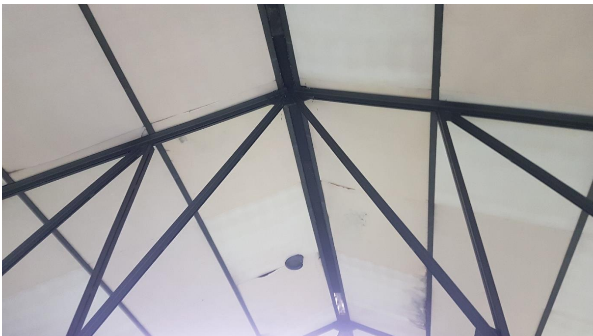
Foto 5: Dakbeschot aan de binnen zijde van de oude schuur.
