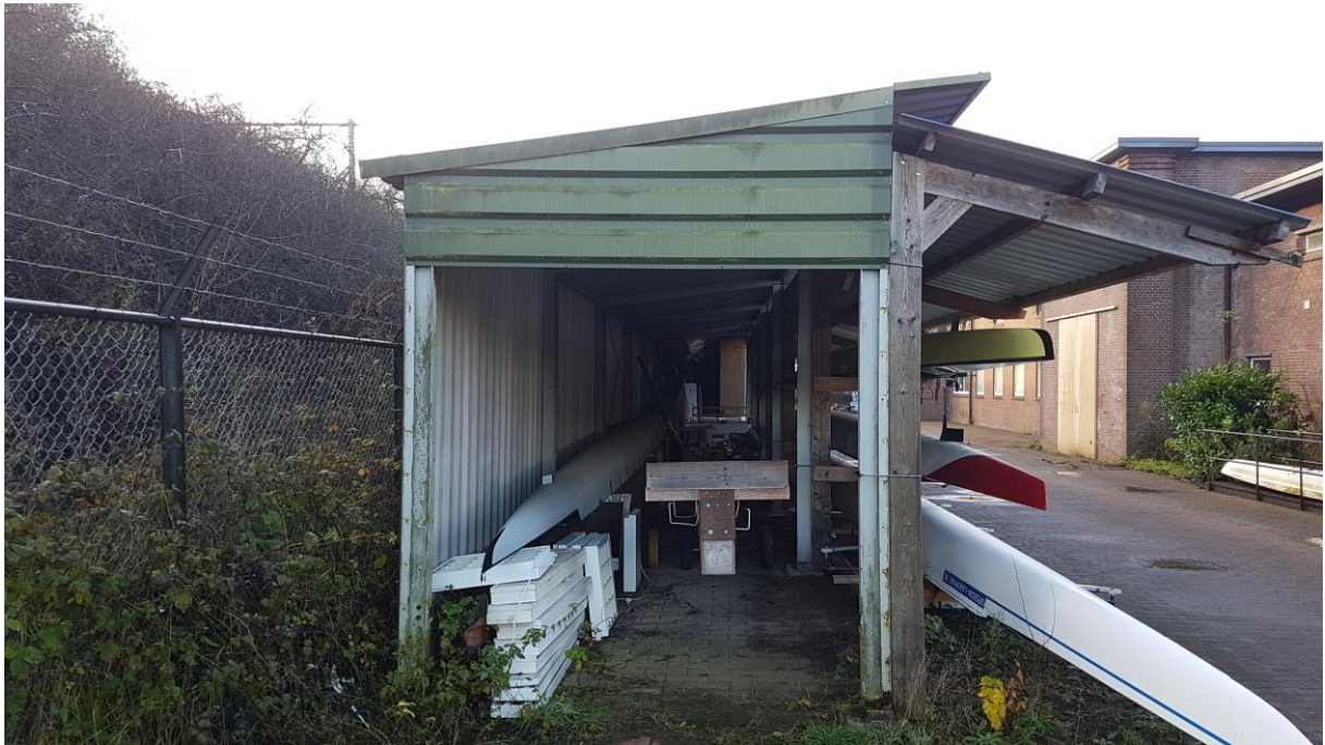
Foto 7: de te slopen overkapping achter het voormalige PGEM-gebouw.
