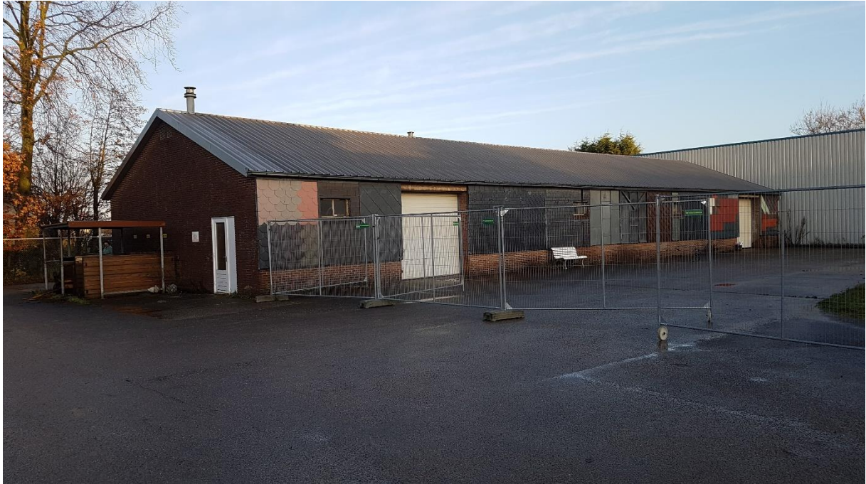
Foto 3: De zuidelijke schuur, met op de gevel sierdakpannen.
