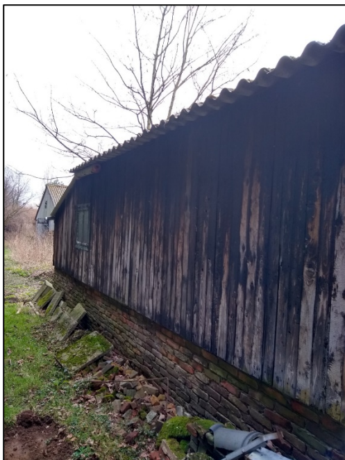
Figuur 2.4 Terreinverkenning, links: dak zonder dakgoot, rechts: open regenpijp.
