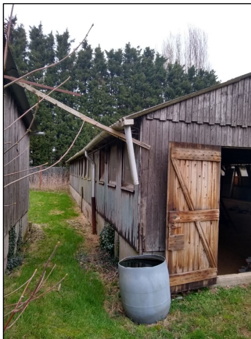
Figuur 2.4 Terreinverkenning, links: dak zonder dakgoot, rechts: open regenpijp.
