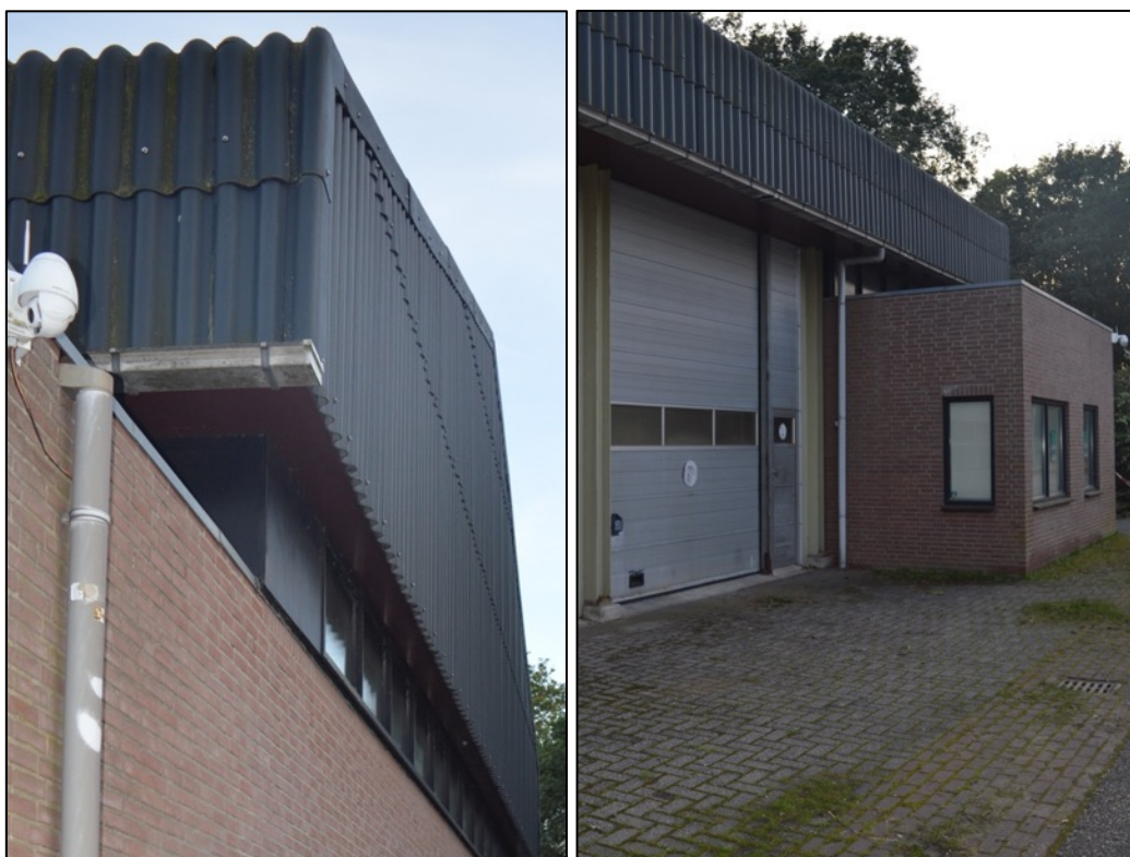
Figuur 3.5 Links: Het dak van de loods sluit strak aan op de laagbouw aan de westgevel. Rechts: De noordkant van de lood (hier maakt de laagbouw ruimte voor roldeuren).
