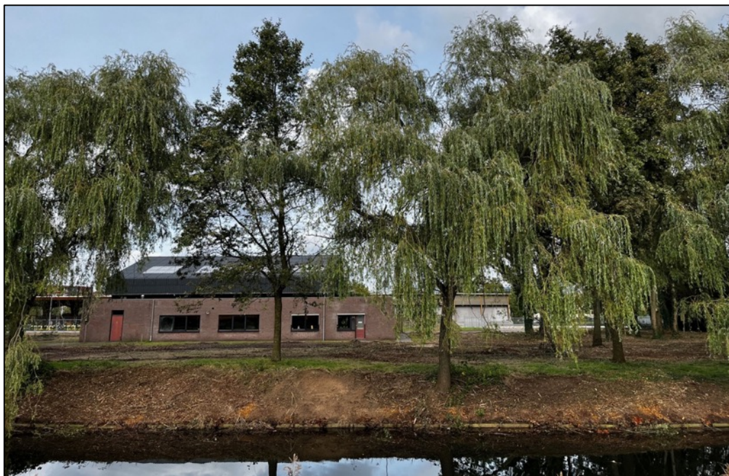
Figuur 2.2 De loods die midden in het onderzoeksgebied staat, met daaromheen (en daar aan vast) laagbouw. Langs de oever staan wilgen, net boven de waterlijn is oeverbeschoot zichtbaar. De oeverzone is recent geschoond.
