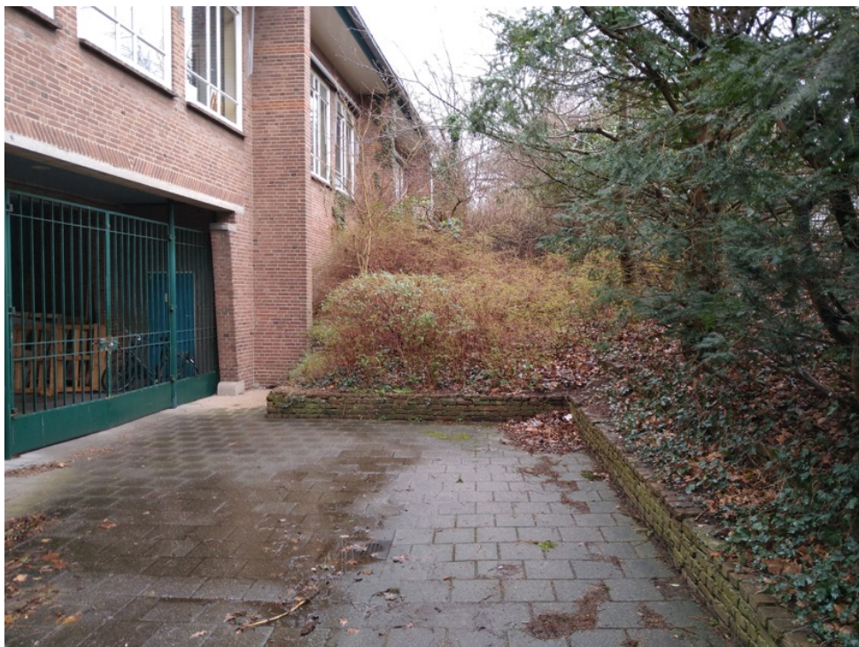
Figuur 2 Zijkant van het schoolgebouw aan de Berg en Dalseweg 293-295 (foto gemaakt op 27-2-2020).
