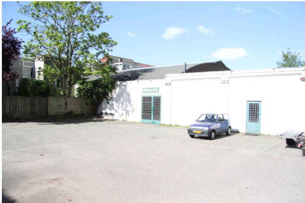
Figuur 5 Oostzijde plangebied met parkeerterrein. Rechts de loodsen en geheel links woningen die aan het plangebied grenzen.
