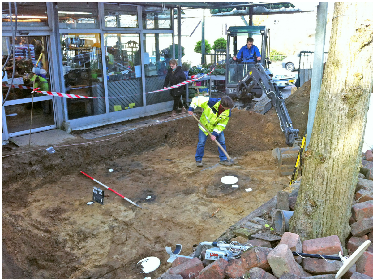
Figuur 3. Aanleg van de opgravingsput voorlangs de westelijke ingangspartij van de winkel. Kijkrichting zuidoost–noordwest.
