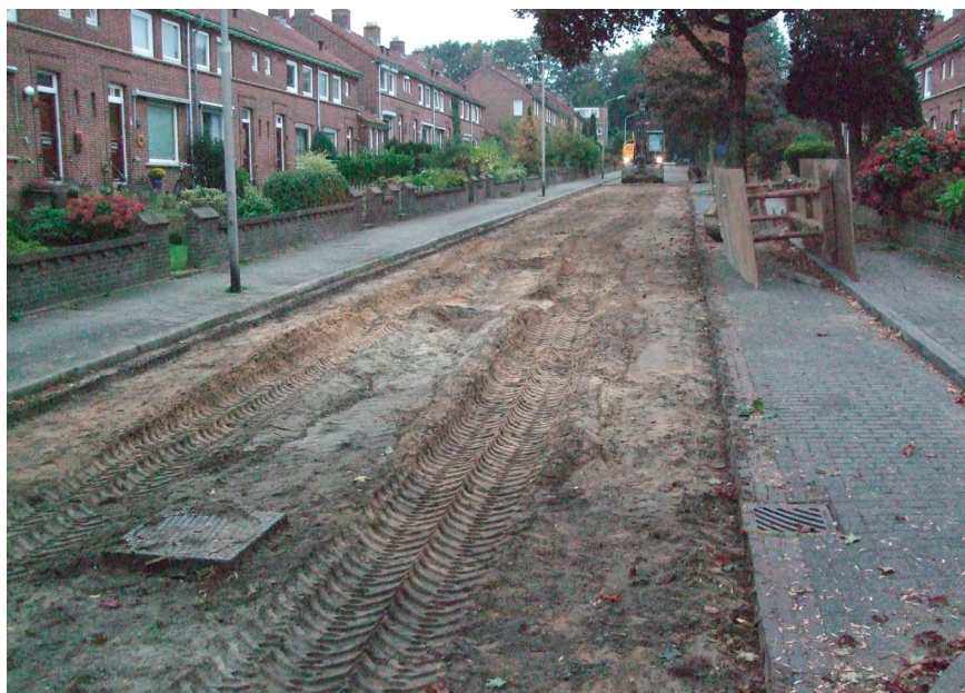
Figuur 3. De Corduenerstraat bij aanvang van de rioolwerkzaamheden.
