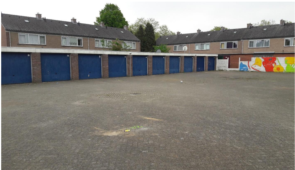
Figuur 2 Het plangebied met zicht op de oostelijke garageboxen.
