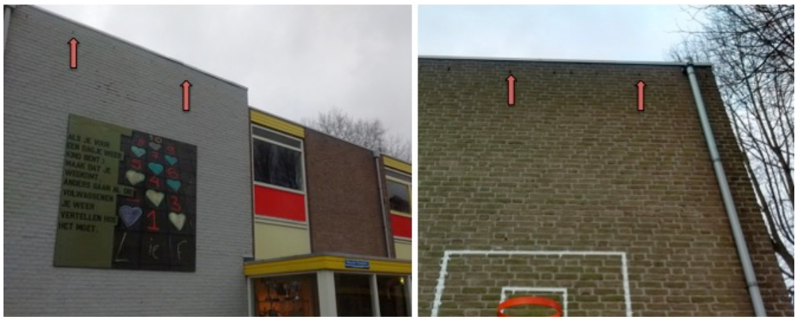
Figuur 3 Foto's schoolgebouw met wegcruipmogelijkheden (rode pijlen) voor vleermuizen
