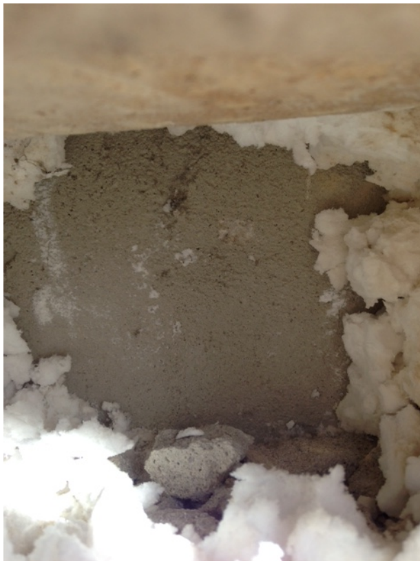
Figuur 4 Foto isolatiemateriaal in spouwruimte (bron: Gemeente Nijmegen)
