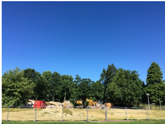
Foto 4: achterzijde schoolgebouw Symfoniestraat 208
