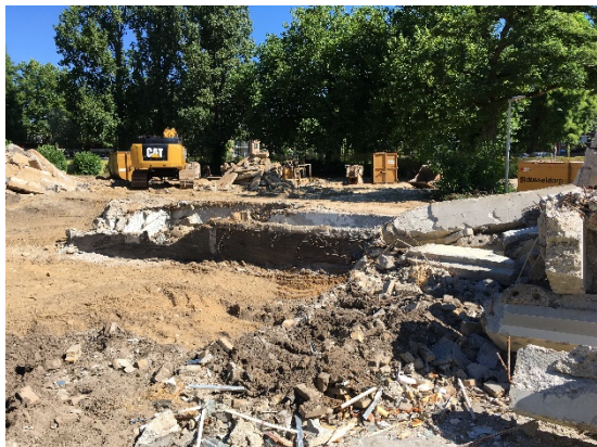
Foto 1: voorzijde voormalig schoolgebouw Symfoniestraat 210
