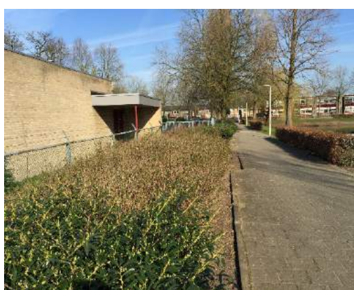
Foto 4: achterzijde schoolgebouw Symfoniestraat 208
