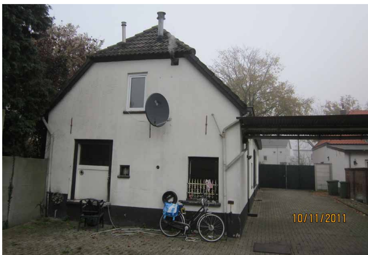
Foto 2: Gezicht op achterzijde winkel/woning aan de Schependomlaan 61-63 te Nijmegen richting noordoosten.
