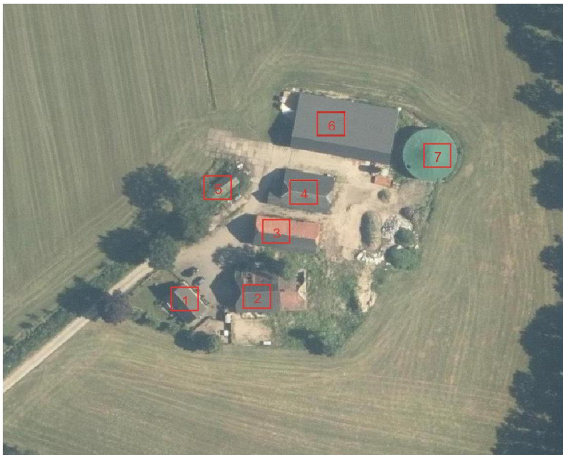
Figuur 2-1 luchtfoto begin 2023
