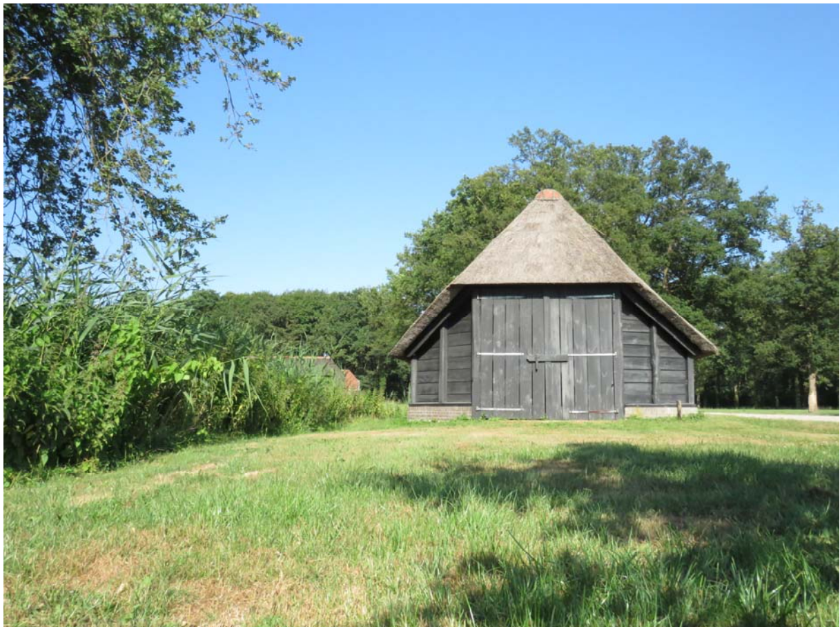
De schaapskooi ligt in de berm van het onverharde toegangspad naar Hoeve de A'Hof
