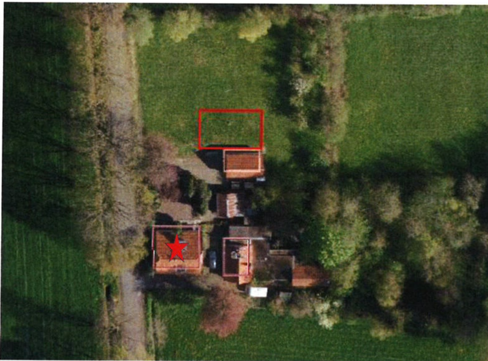
Afbeelding 1: Planlocatie Weldammerlaan 8 in Hoevelaken
