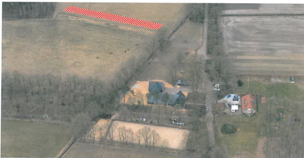
Afbeelding 1. Landgoed De Prinsenkamp, beoogde locatie zonnepanelen (rood gearceerd)
