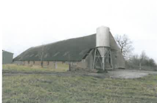
De koeienstal vanuit het zuiden gezien
