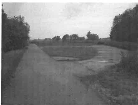
Foto 1: Nekkeveld (asfaltweg) met rechts een betonpad en verharding met recyclinggranulaat
