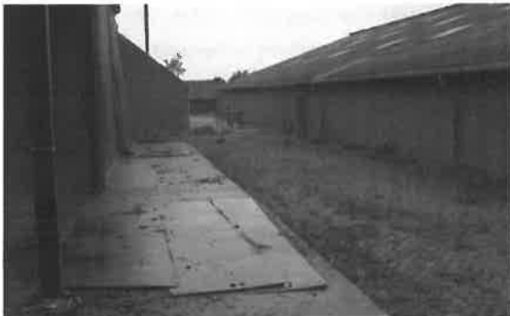
Foto 5: Ruimte tussen schuren met beton- en klinkerverharding
