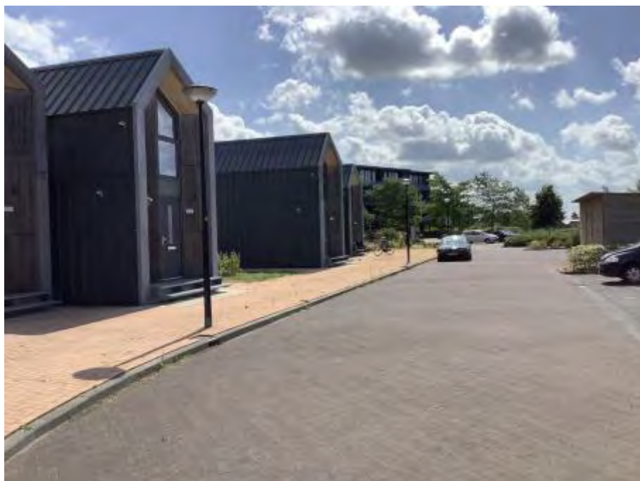
Locatiefoto 7 noordelijk terreindeel
