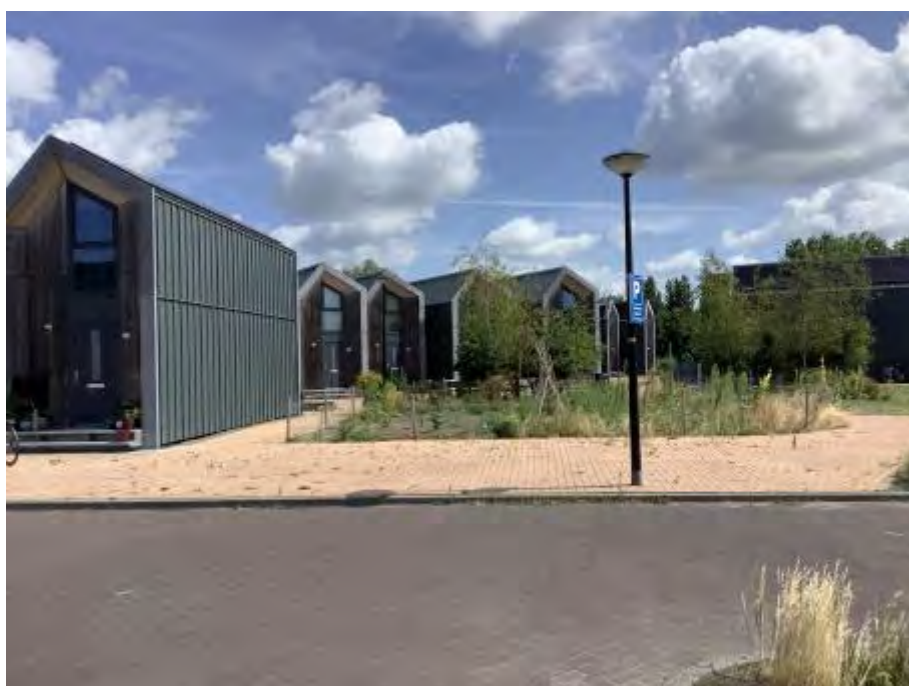
Locatiefoto 8 noordelijk terreindeel
