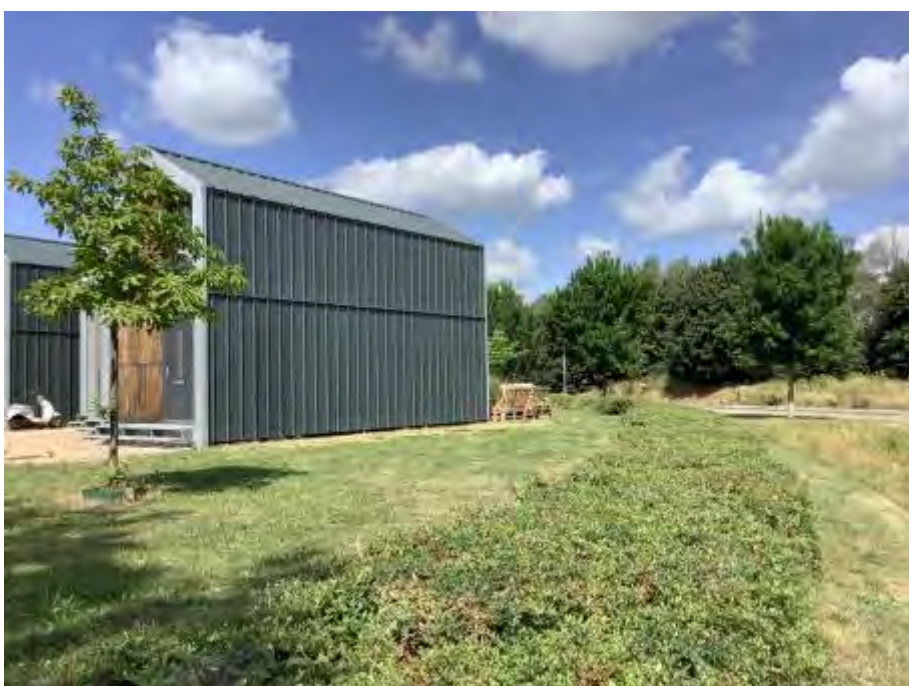
Locatiefoto 4 noordelijk terreindeel
