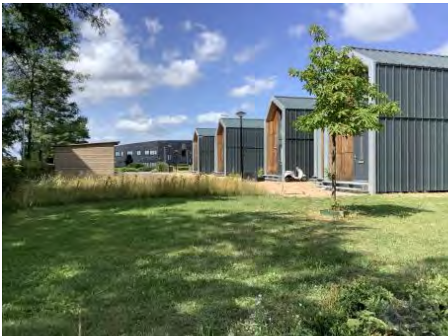
Locatiefoto 3 noordelijk terreindeel
