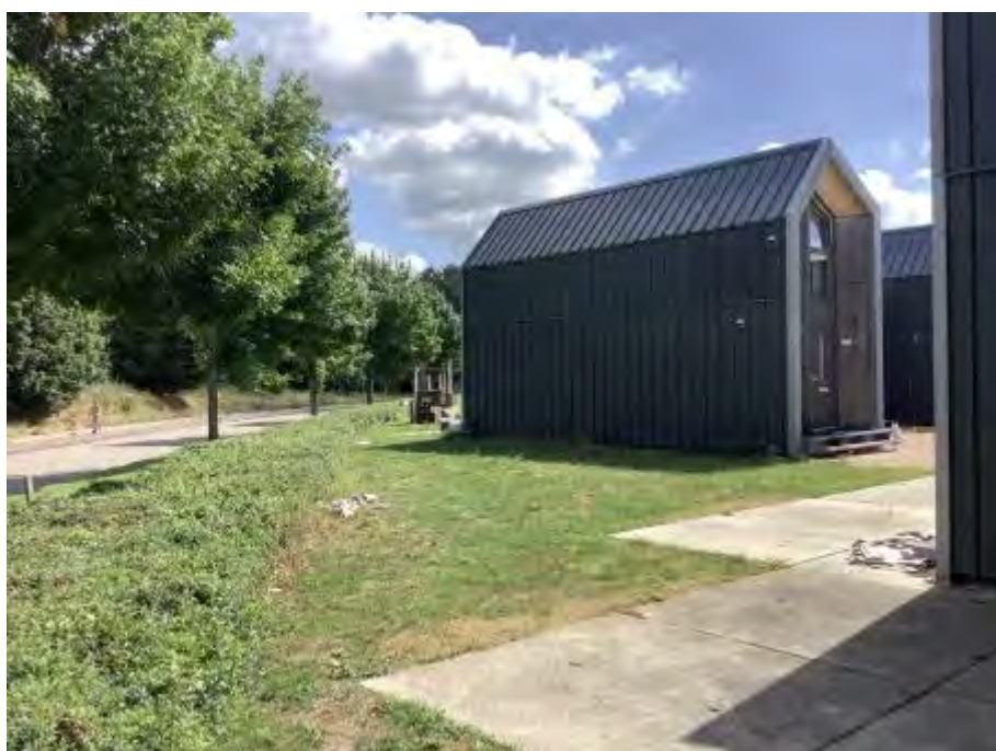
Locatiefoto 6 noordelijk terreindeel
