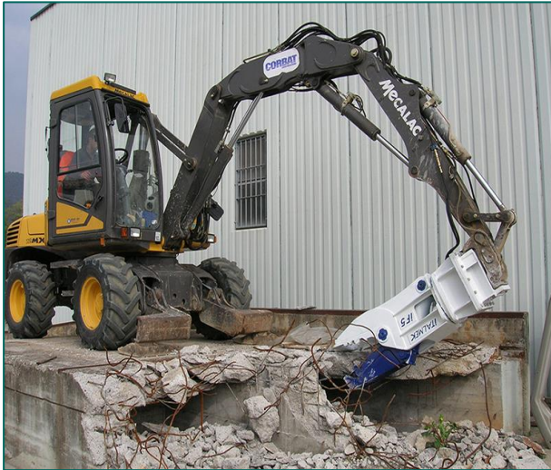
Figuur 38. Trillingsarm slopen middels betonschaar.
