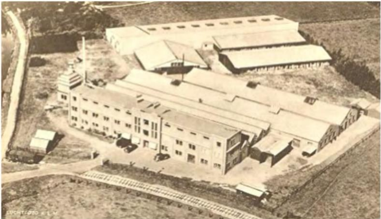
Figuur 22. Luchtfoto van de meubelfabriek Tijsseling n.d. (bron: Historisch Bodemonderzoek PJ Milieu BV, 1554601H, d.d.27 november 2015).
