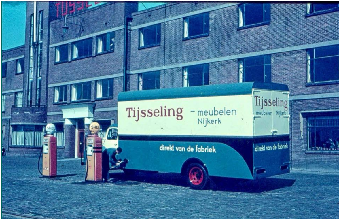
Figuur 24. Pompstation behorende bij fabriek Tijsseling n.d. (bron: Nijkerkinfo's).
