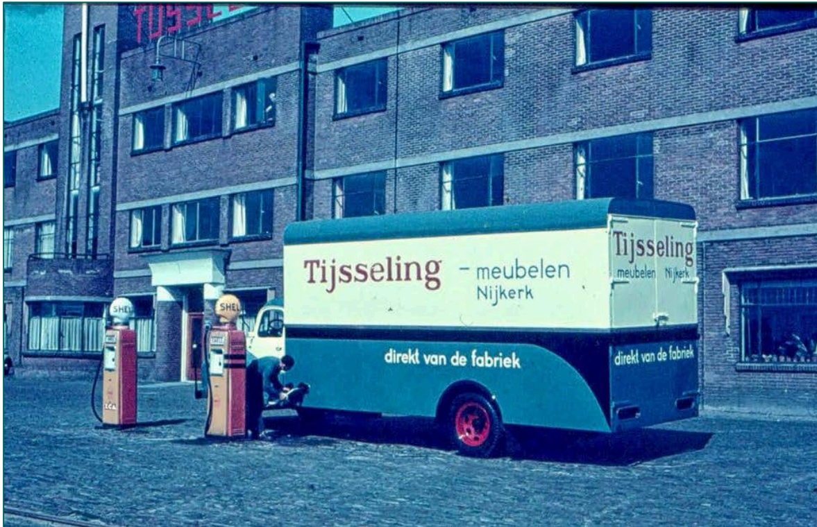
Figuur 22. Pompstation behorende bij fabriek Tijsseling n.d. (bron: Nijkerkinfo's).
