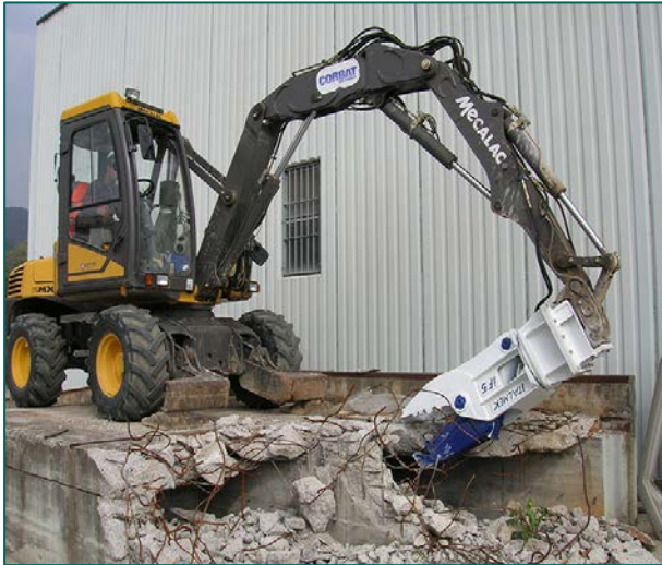
Figuur 36. Trillingsarm slopen middels betonschaar.
