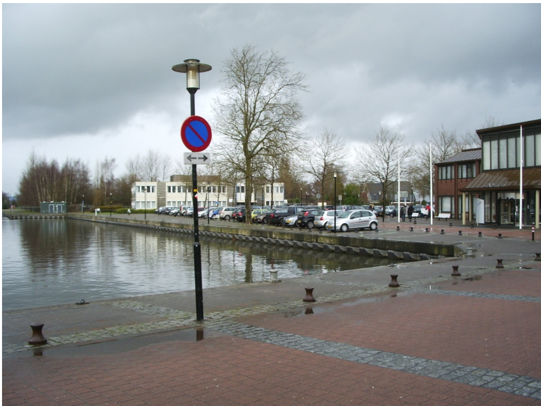
Afb. 21 Foto plangebied met deel haven en nieuwe deel gemeentehuis met parkeerterrein (12-01-2017).
