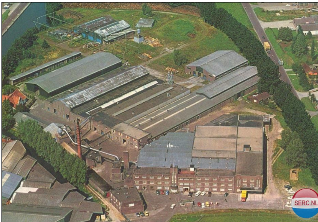
Afb. 14 Luchtfoto uit de jaren 70 van de vorige eeuw met het noordelijk deel van het plangebied. Hierop staat het voormalige industriële gebouwencomplex van meubelzaak Tijsseling. 47
