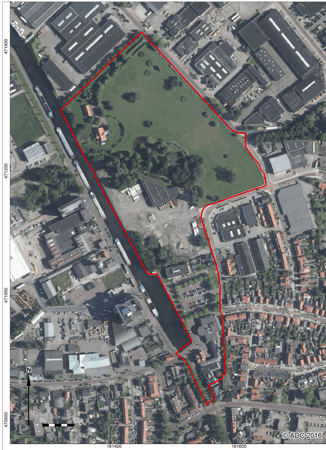
Afb. 3 Luchtfoto van het plangebied.
