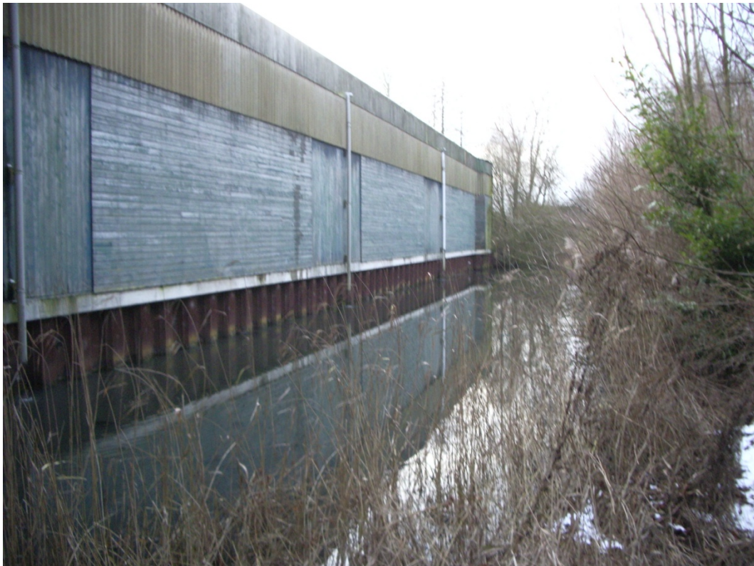
Afb. 24 Foto deels gedempte binnenvaart met damwandversterking en opslaghal (16-01-2017).
