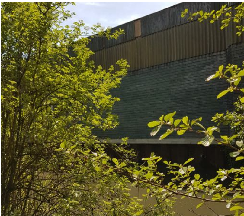
Figuur 6 Het waterlichaam ligt direct tegen de loods op het voormalige industrieterrein.
