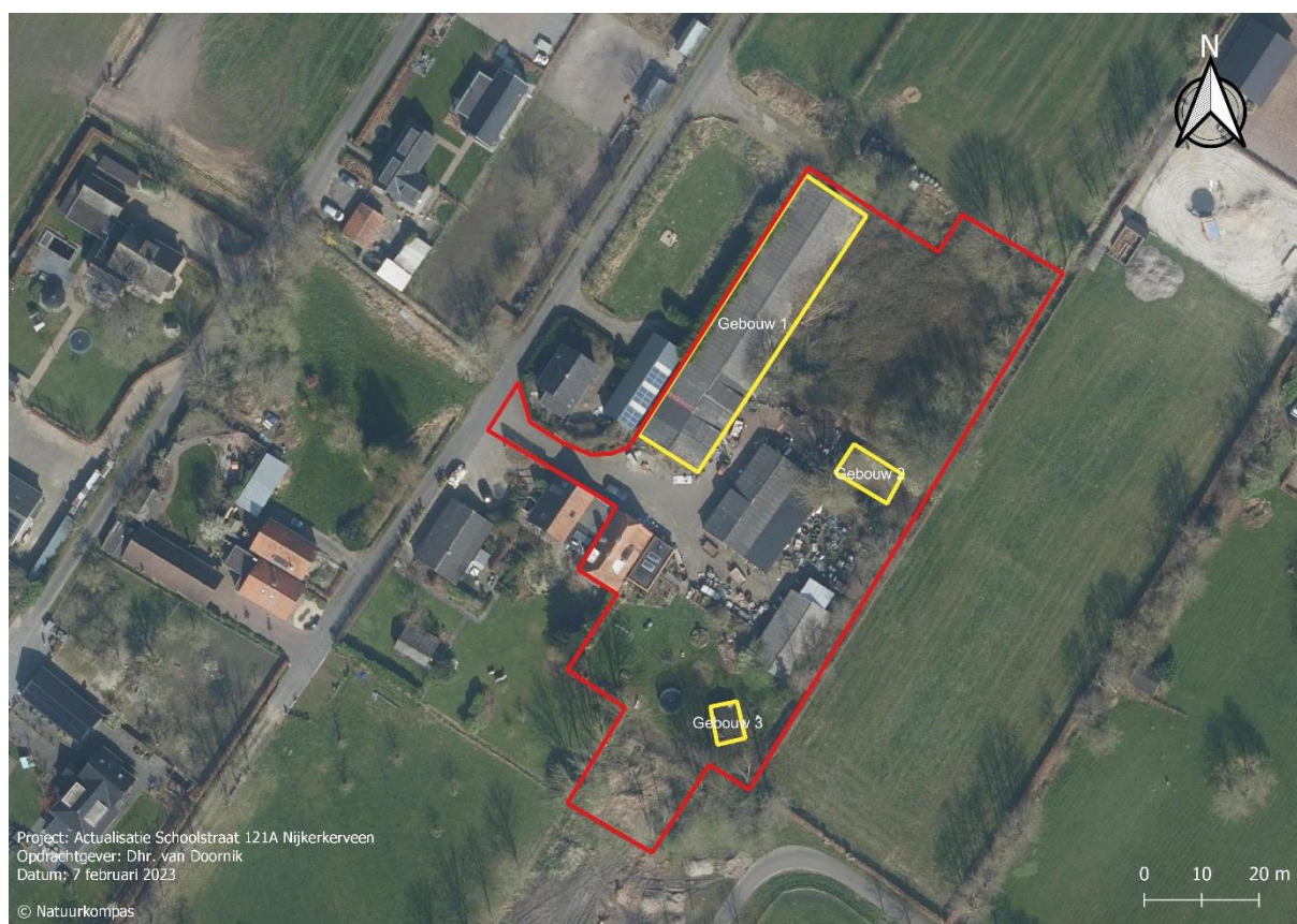
Afbeelding 3.1: Luchtfoto met ligging van het plangebied (rood omlijnd) en de te slopen bebouwing (geel omlijnd en genummerd). Bron: PDOK services, 2023. Bewerking: Natuurkompas, 2023.
