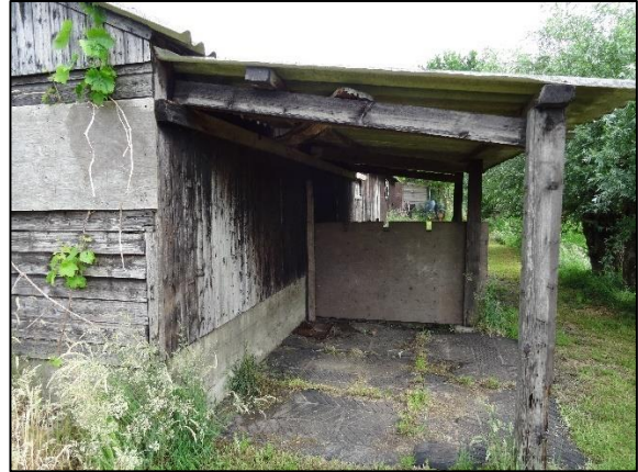
Fig. 2.15 Overkapping achter gebouw nr. 4 (bron: FF Solutions)
