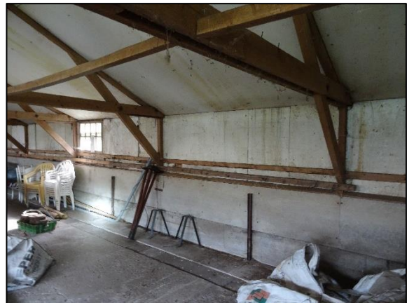
Fig. 2.17 Isolatie gebouw nr. 4, ook op wanden (bron: FF Solutions)
