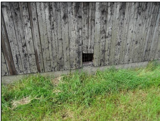
Fig. 2.4 Met rooster dichtgemaakte opening gebouw nr. 1 (bron: FF Solutions)
