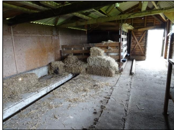
Fig. 2.9 Binnenzijde gebouw nr. 2 (bron: FF Solutions)
