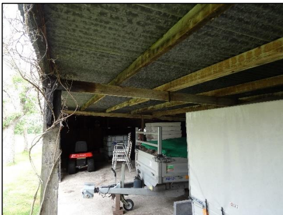
Fig. 2.12 Overkapping gebouw nr. 3 (bron: FF Solutions)
