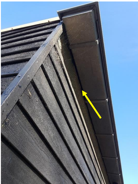
Figuur 5. Openingen onder de dakgoot die vleermuizen toegang kan bieden tot de veeschuur (gele pijl).
