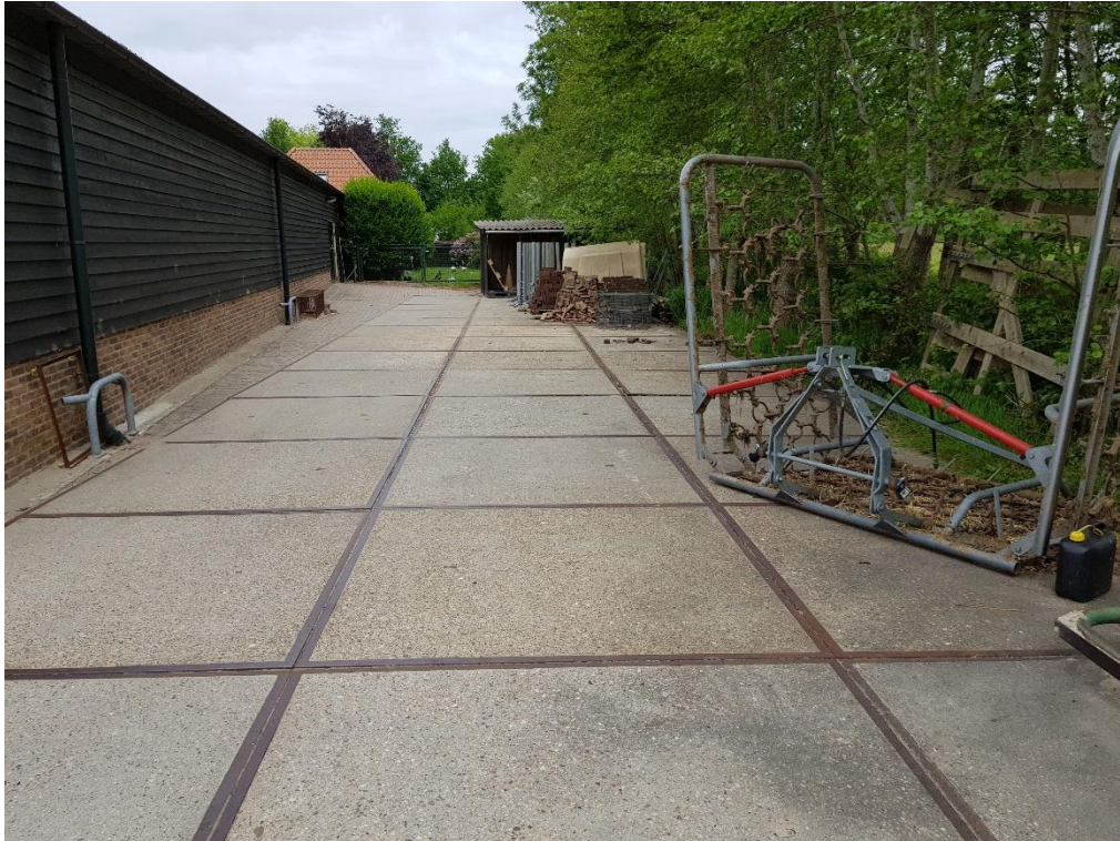
Oostzijde paardenstalling (stelconplaten)
