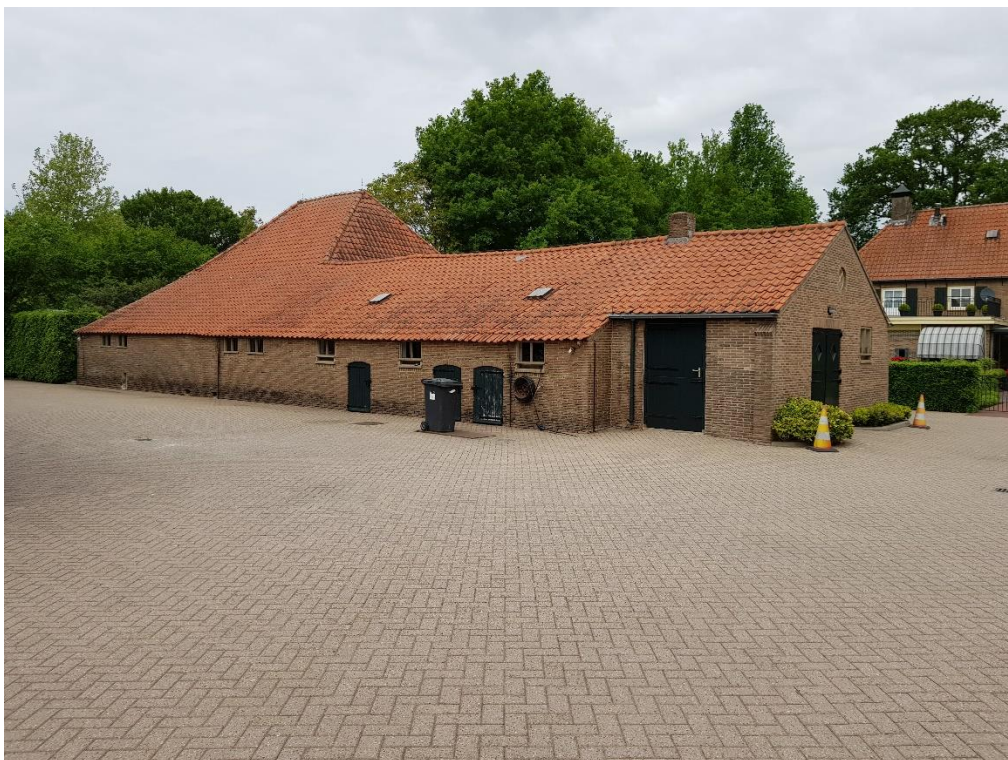
Erf met schuur en woning/kantoor (achtergrond)
