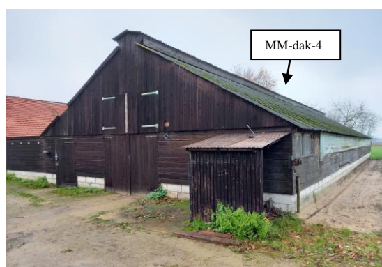
Foto 18: Geïntervieweerde schuur 4 met asbesthoudende golfplaat als dakbedekking vanuit oostelijke richting gezien.
