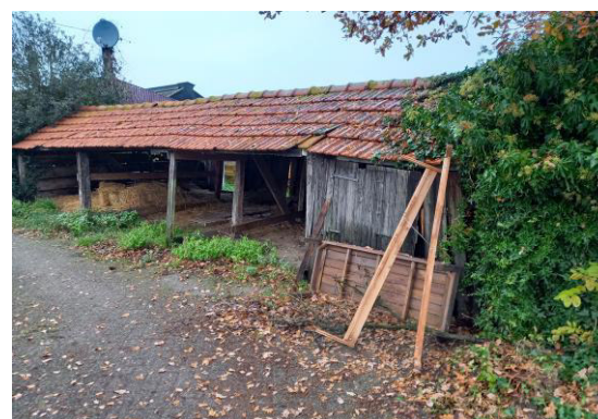
Foto 24: Geïntervieweerde schuur 7 vanuit zuidelijke richting gezien. (geen asbest waargenomen)
