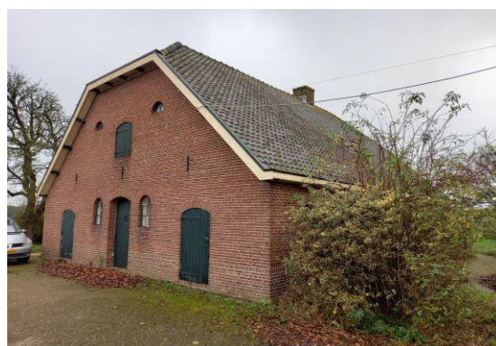
Foto 4: Geïntervieweerde woning vanuit noordwestelijke richting gezien.
