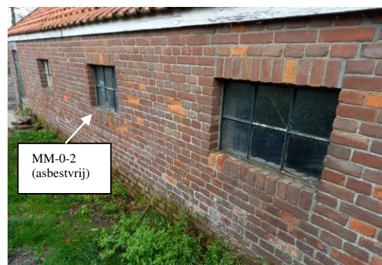
Foto 10: Asbestvrije stopverf in/aan de raamkozijnen van schuur 3.
