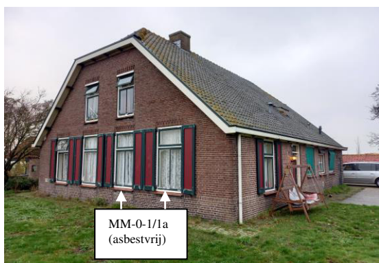
Foto 3: Geïntervieweerde woning met asbestvrije stopverf in/aan raamkozijnen vanuit zuidoostelijke richting gezien.
