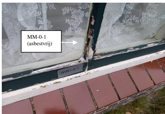
Foto 1: Asbestvrije stopverf in/aan de raamkozijnen van de woning.
