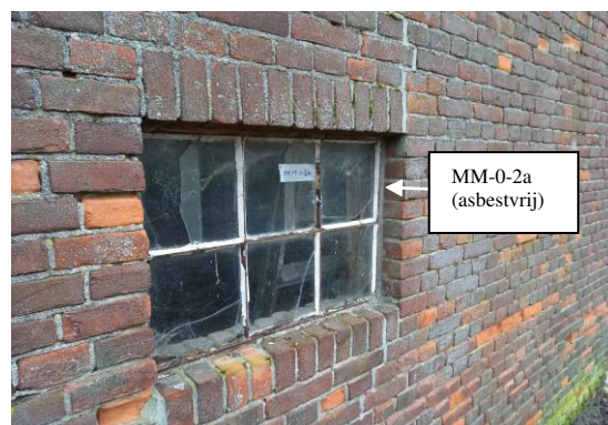
Foto 10: Asbestvrije stopverf in/aan de raamkozijnen van schuur 3.
