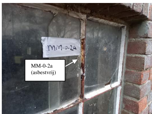
Foto 11: Asbestvrije stopverf in/aan de raamkozijnen van schuur 3.
