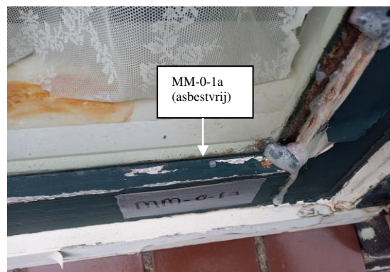
Foto 2: Asbestvrije stopverf in/aan de raamkozijnen van de woning
