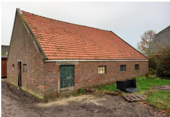
Foto 13: Geïntervieweerde schuur 3 vanuit zuidwestelijke richting gezien.
