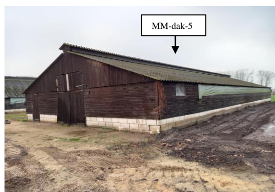
Foto 22: Geïntervieweerde schuur 5 met asbesthoudende golfplaat als dakbedekking vanuit oostelijke richting gezien.
