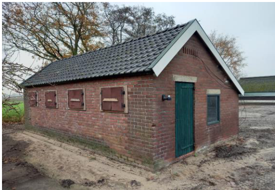
Foto 25: Geïntervieweerde schuur 8 vanuit zuidoostelijke richting gezien. (geen asbest waargenomen)
