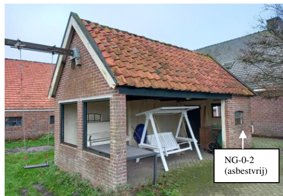
Foto 8: Geïntervieweerde schuur 2 met asbestvrije stopverf (identiek aan MM-0-2/MM-0-2a) in/aan 2 raamkozijnen vanuit zuidwestelijke richting gezien.
