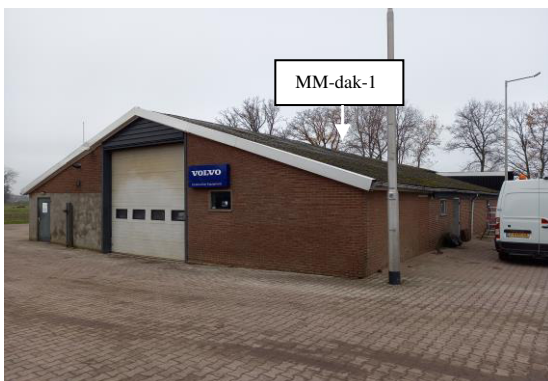
Foto 3: Geïntervieweerde schuur met asbesthoudende golfplaat als dakbedekking vanuit zuidelijke richting gezien.
