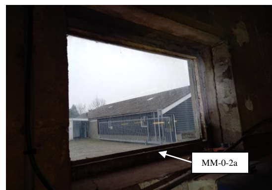
Foto 10: Asbesthoudende stopverf in/aan de raamkozijnen van de schuur.
