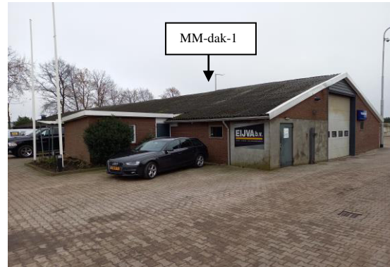
Foto 2: Geïntervieweerde schuur met asbesthoudende golfplaat als dakbedekking vanuit zuidwestelijke richting gezien.
